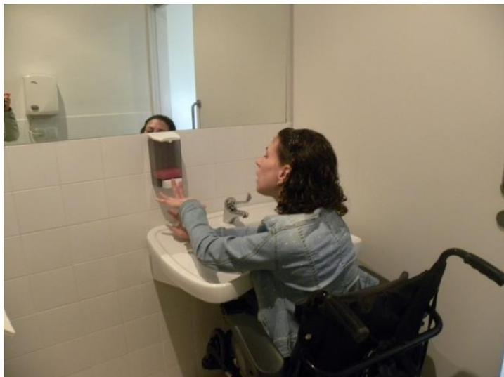
está accesible, sin embargo la ubicación del enchufe junto al lavabo no es accesible. El mecanismo del dosificador de jabón resulta difícil de usar. El borde inferior del espejo está excesivamente alto.
