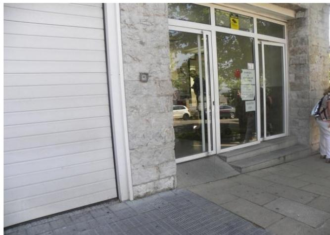
Pendiente longitudinal de la rampa excesivamente elevada. Con una silla manual se necesita una persona para que ayude a subir y bajar y otra que aguante la puerta. Con silla eléctrica también necesita que alguien aguante la puerta y hay peligro de vuelco
