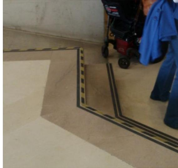
La rampa alternativa a estos escalones tiene una pendiente excesiva.
