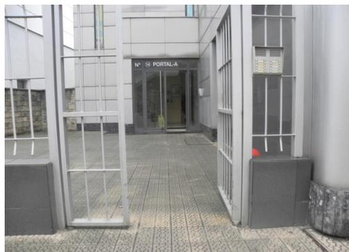
El acceso a este ascensor no es accesible: la hoja móvil de la puerta del portal tiene un ancho útil de paso de 70cm por lo que puede ser que sea necesario abrir la otra hoja para poder pasar.
